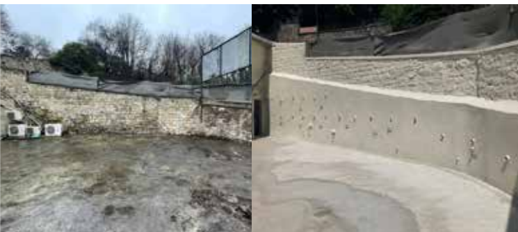
La comparaison entre avant les travaux (à gauche) et après (à droite) est saisissante.
